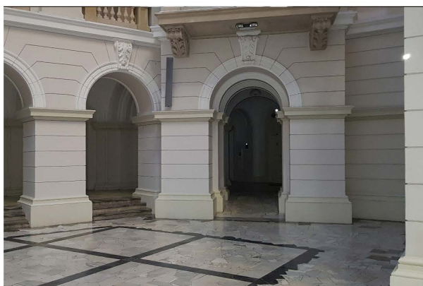
Rampa w przestrzeni głównej, umożliwiająca zjechanie na poziom głównej auli
