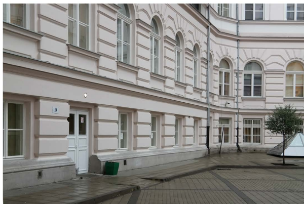
Pochylnia umożliwiająca znalezienie się na poziomie krawężnika
