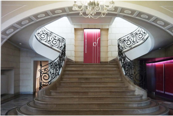
Stopnie schodów znaczone ciemnymi, kontrastującymi taśmami
